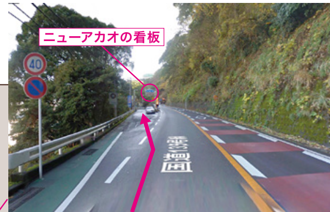
熱海方面より二股箇所
